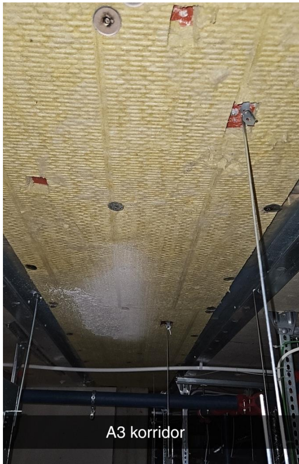
Figur 9 – Det er hull i brannisolasjon pga. teknikk, og hullene bør tettes.
