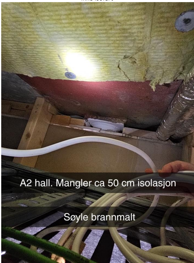
Figur 7 – Stålet er uisolert
