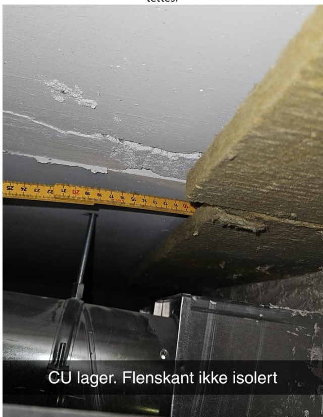
Figur 9 – Det er hull i brannisolasjon pga. teknikk, og hullene bør tettes.
