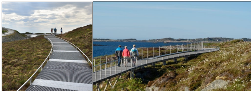
Illustrasjon av hvordan en «svevesti» kan se ut. Bildene er fra Nasjonale turistveger, Atlanterhavsvegen. De viser rasteplassen og utsiktspunktet Eldhusøya. Foto: Roger Ellingsen, Statens vegvesen
