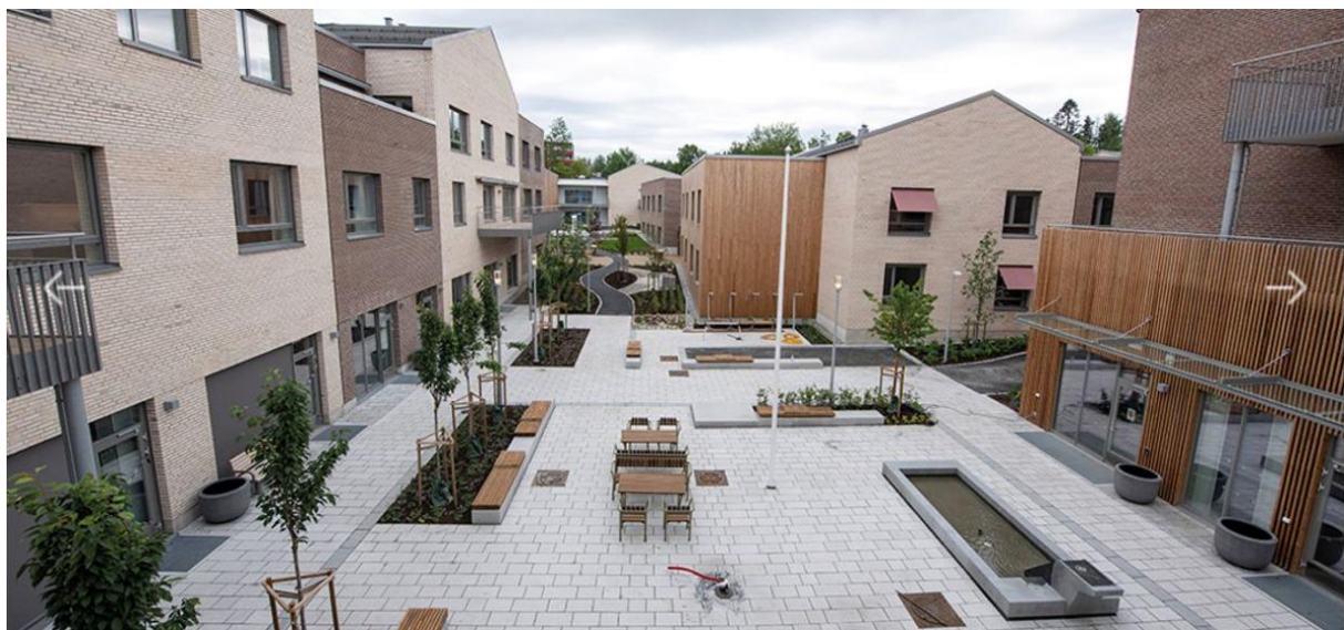
Figur 5 Øverst Carpe Diem sett fra lufta, med det grønne uterommet sentralt i anlegget, og adkomstområdet med kafé og torget bakerst. Under bilde fra torget, med det grønne uterommet i bakgrunnen. Foto: Trond Joelson, Byggeindustrien
