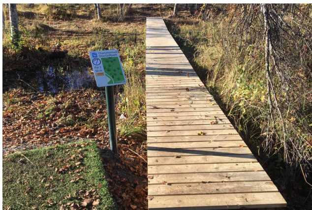
Skoggruppa Miljøtjenesten Sør-Tromsøya bygget plankeganger til discgolfbanen
