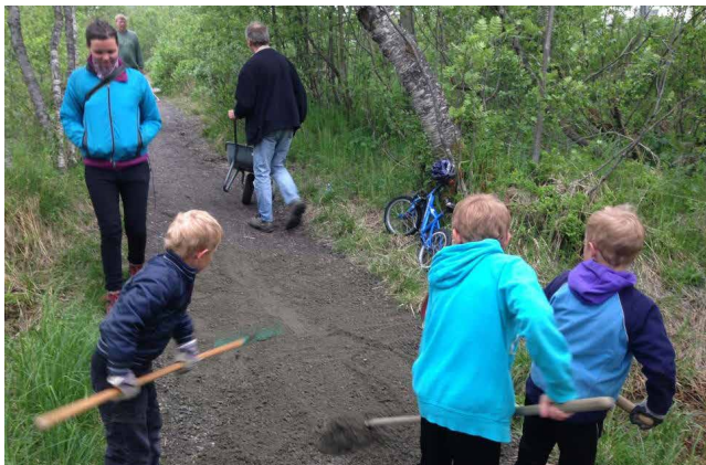
Borgtun bydelsråd rustet opp turveien fra Grimsbyveien til Charlottenlund
