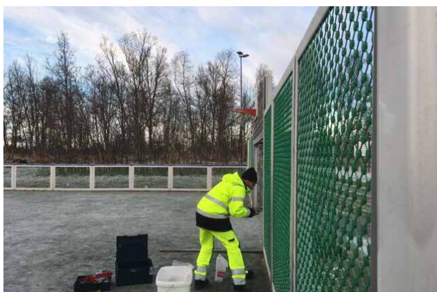
Setter opp nye vegger i ballbingen på Charlottenlund
