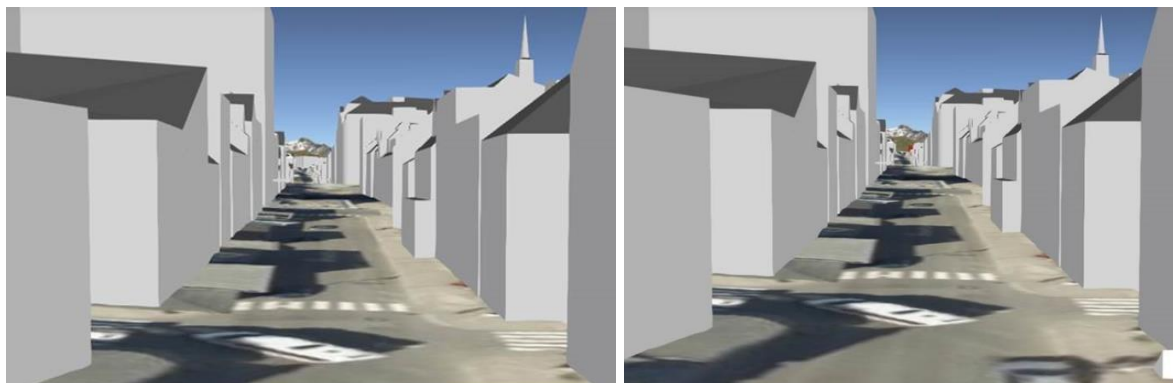
Utsikt fra Storgata mot nord. Venstre: med nyetablert leilighetsbygg «the Box» i Stakkevollvegen 11: ikke synlig. Høyre: Tårn i nordøstre del av Kræmer Brygge nordøst (vist med rødt) ville så vidt vært synlig hvis ikke det nye leilighetsbygget «the Box» allerede var etablert.
