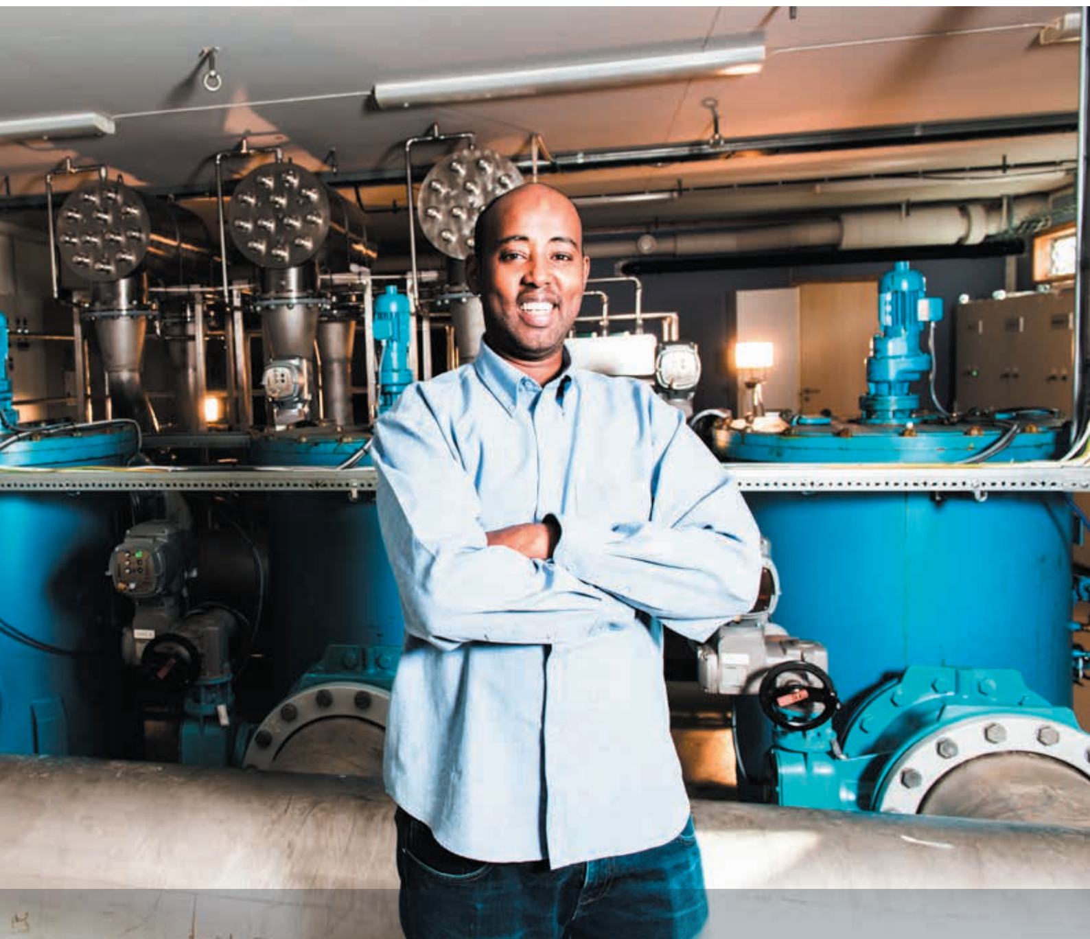
Automasjonsingeniør Adbi-Aziz-Meqbul foran vannbehandlingsanlegget på Kvaløya.
