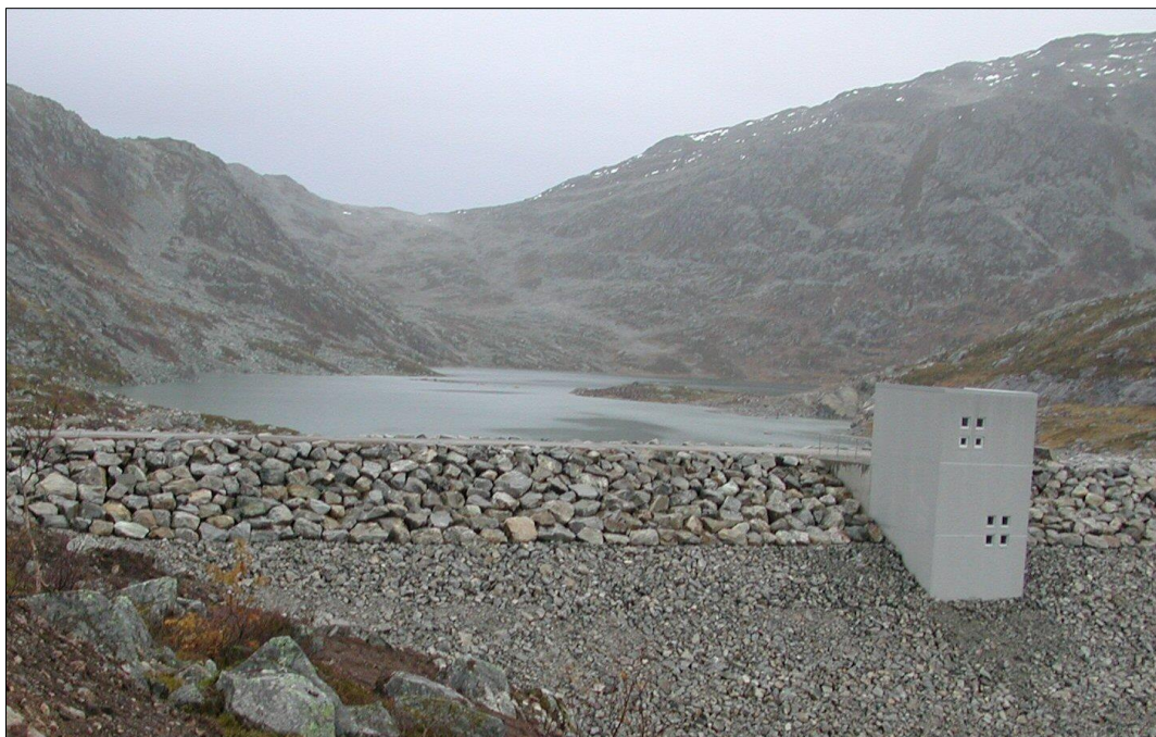
Figur 10: Damanlegget ved Øvre Langvatn.
