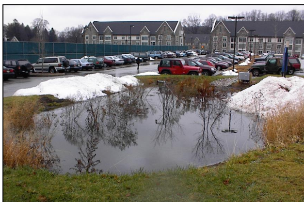
Fig. 26: Regnbed som rensiltak for forurenset snø fra parkeringsplass
