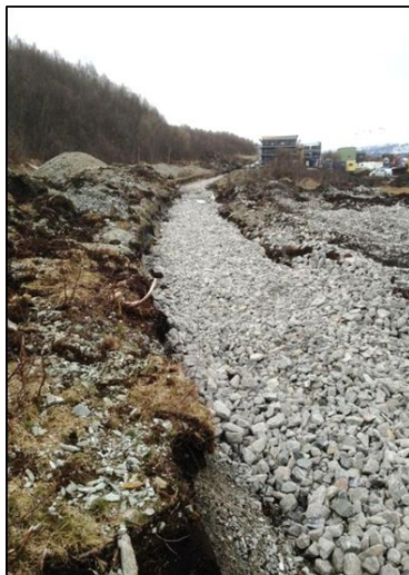
Fig. 21: Avskjærende bekk ovenfor bebyggelsen
