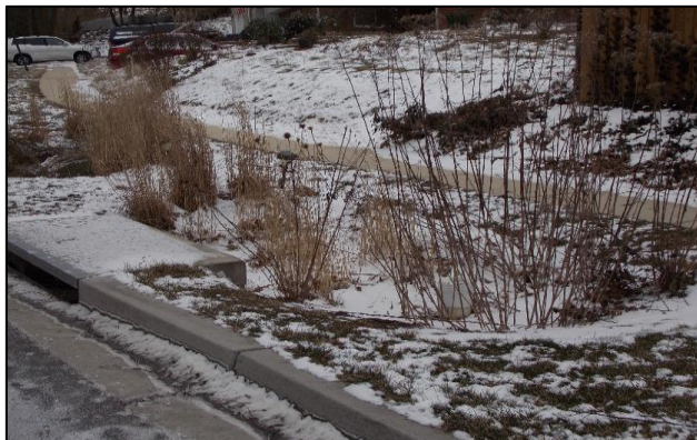
Fig. 24: Regnbed for rensing av vegvann (A. Gillespie)
