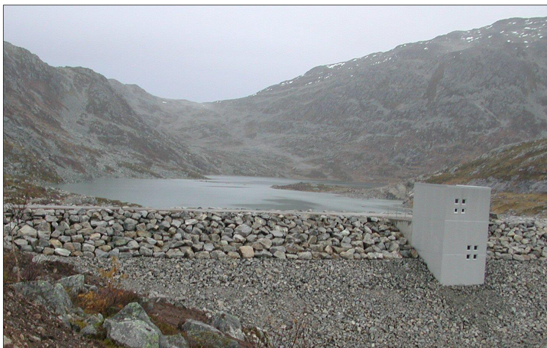
Figur 10: Damanlegget ved Øvre Langvatn.
