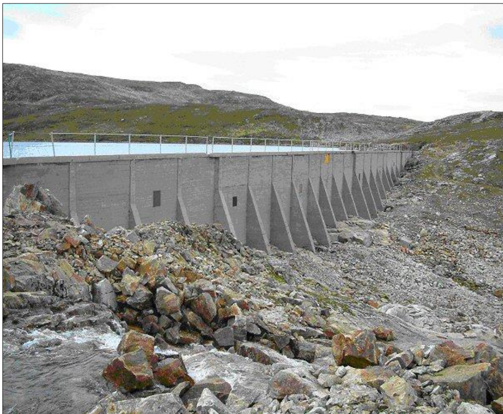
Figur 9: Damanlegget ved Amundvatnet.
